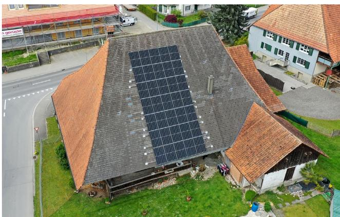
«Flugaufnahme» der fertig installierten Photovoltaik-Anlage mit 15.4 kWp.
