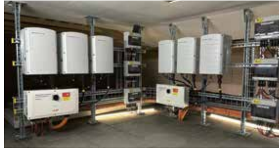
Zwei Wechselrichter mit je 100 kVA wurden im Hapimag Resort Ascona eingesetzt.
