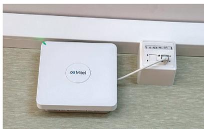
SIP-Dect-Sender mit neuen UKV-Steckdose unterhalb des Installationskanals.
