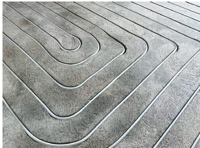
Die Verlegung der Rohre in die eingefrästen Rillen ist energietechnisch von Vorteil.
