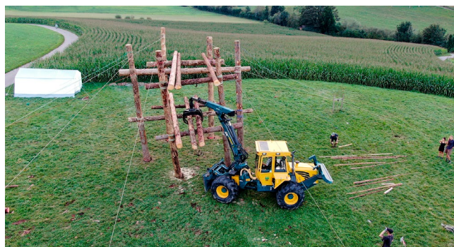
Dank dem Bagger mit Kranarm liessen sich die massiven Holzstämme einfach hochheben.
