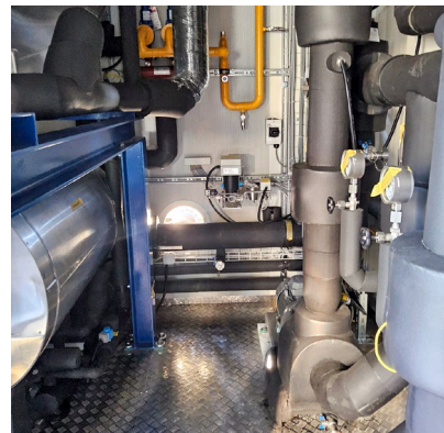
Arbeiten auf engem Raum.
