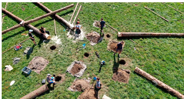
Am Jubiläumsfestival 2024. Für den Aussichtsturm mussten 6 tiefe Löcher ausgehoben werden.
