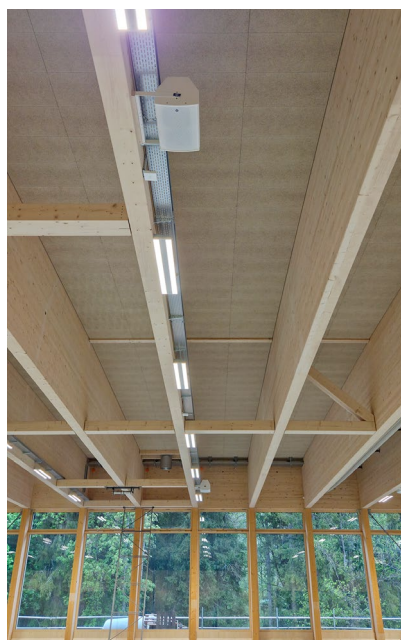
Installationen in der Turnhalle.
