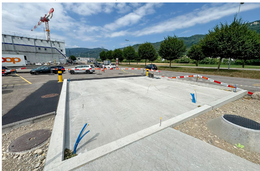
Vorbereitete Bodenplatte mit Bodenleitungen.
