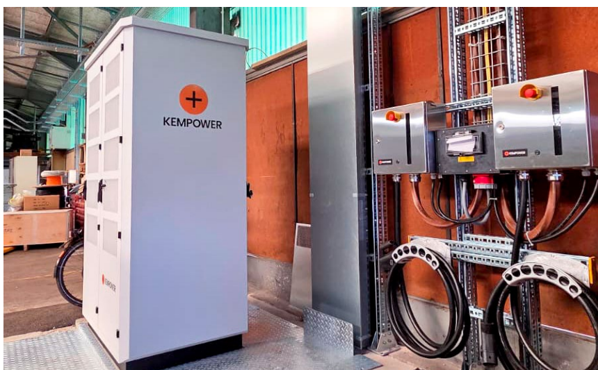
Gleichrichter mit Installation.
