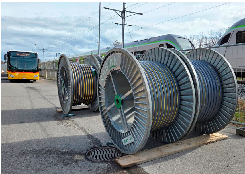
Die Bobinen mit den «voluminösen» Kabeln stehen bereit.
