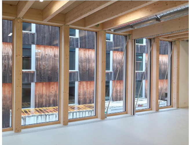
Mehrzweckraum im Obergeschoss.
